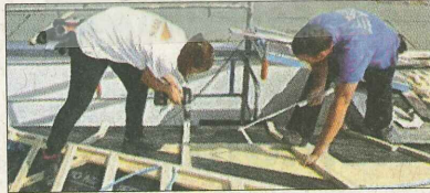
Arbeiten auf dem Dach. Firmenfoto
